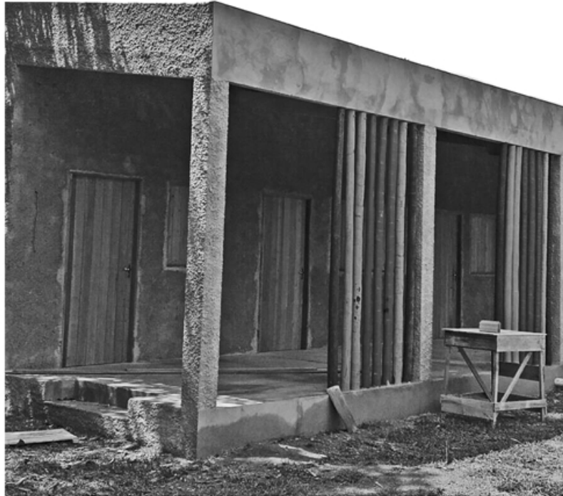
fasi di realizzazione in cantiere del centro/ricovero
