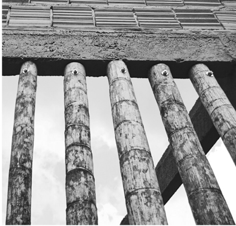
processo di realizzazione della schermatura con acai
